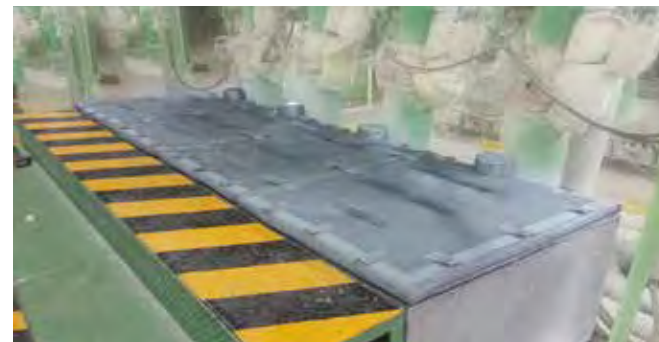
▲ 플렉스쉴드 - 케미컬사 고온용 반응기 표면 덮개 설치 공사 (Removable cover)
