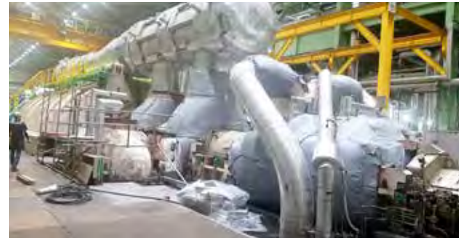
▲ 플렉스쉴드 - 발전소 터빈 HP/IP-TBN, BFP-TBN, 각종 감육 포인트 등 보온 케이싱 설치 공사 (Removable cover)
