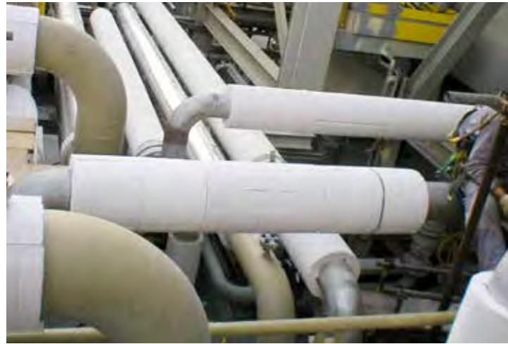
▲ 슈퍼라이트 - 케미컬사 파이프 커버 설치 공사
