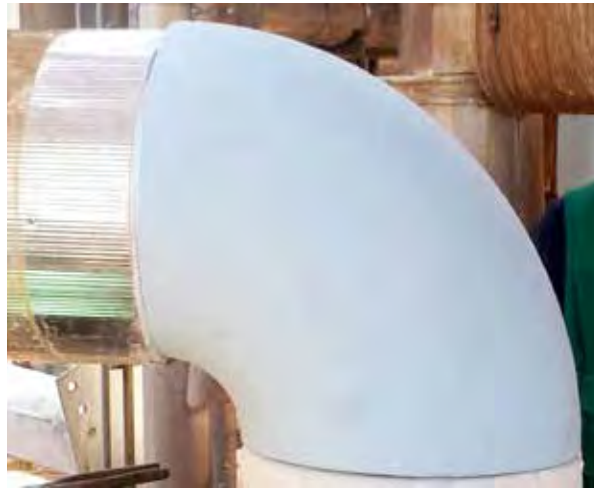
▲ 하이퍼라이트 - 케미컬사 엘보우 커버 부분 교체 공사
