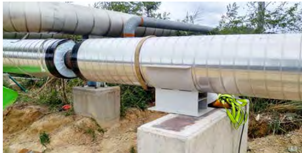
▲ 울트라쉴드와 하이퍼라이트의 복합 시스템 - 이중 보온관 설치 공사
