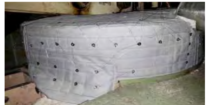
▲ 플렉스쉴드 - 발전소 터빈 HP/IP-TBN, BFP-TBN, 각종 감육 포인트 등 보온 케이싱 설치 공사 (Removable cover)
