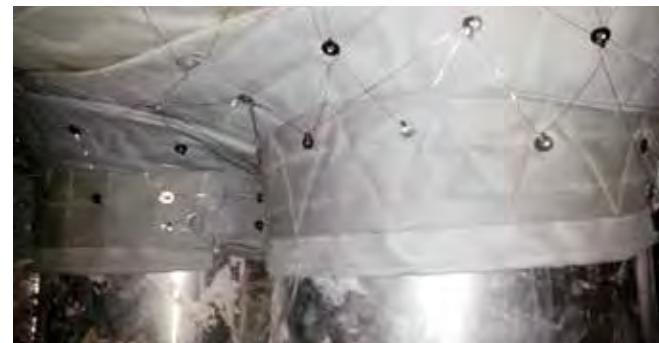
▲ 플렉스쉴드 - 석탄 화력발전소 터빈 설비 보온 케이싱 보강/교체 공사 (Removable cover)
