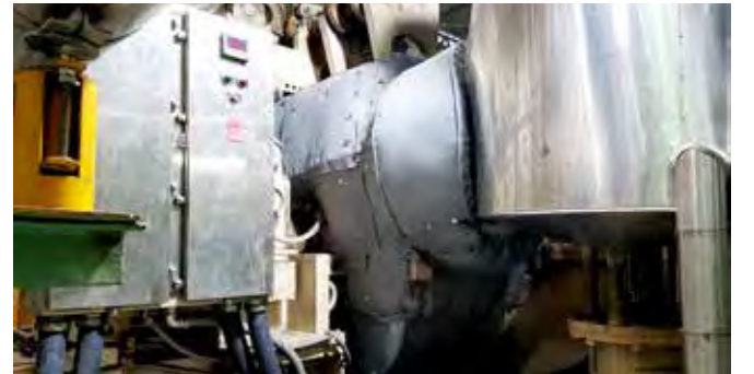
▲ 플렉스쉴드 - 발전소 터빈 HP/IP-TBN, BFP-TBN, 각종 감육 포인트 등 보온 케이싱 설치 공사 (Removable cover)
