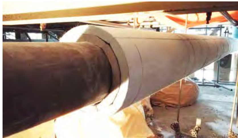
▲ 울트라쉴드 - 케미컬사 협소부위 파이프 커버 설치 공사
