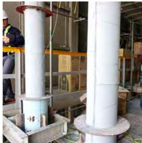
▲ 울트라쉴드 - 케미컬사 파이프 커버 설치 공사
