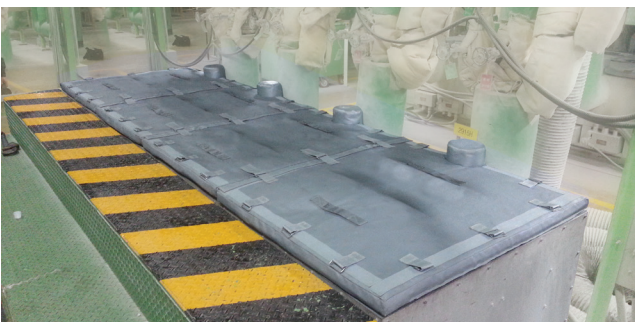
플렉스섬 케미컬사 고온용 반응기 표면 덮개 설치 공사 (Removable cover)
