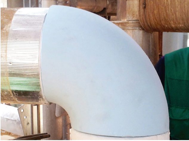
하이퍼라이트 케미컬사 엘보우 커버 부분 교체 공사
