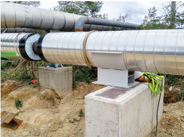
울트라썸과 하이퍼라이트의 복합 시스템 이중 보온관 설치 공사
