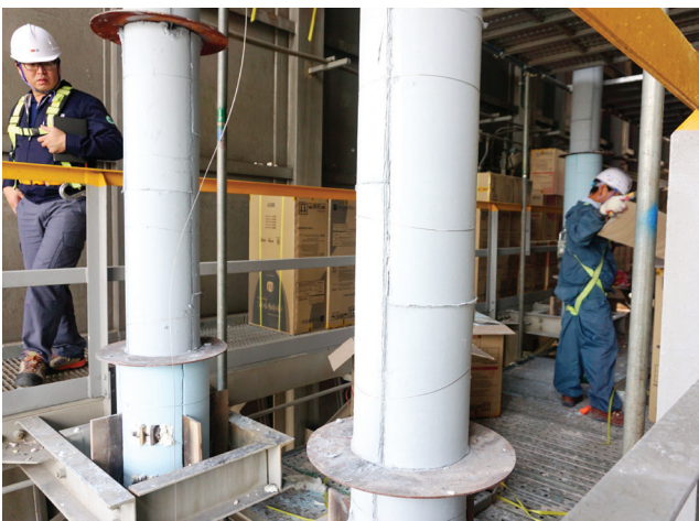
울트라썸 케미컬사 파이프 커버 설치 공사 / 케미컬사 협소부위 파이프 커버 설치 공사
