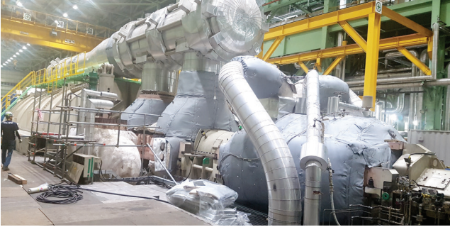
플렉스섬 화력발전소 터빈 HP/IP-TBN, BFP-TBN, 각종 감육 포인트 등 보온 케이싱 설치 공사 (Removable cover)
